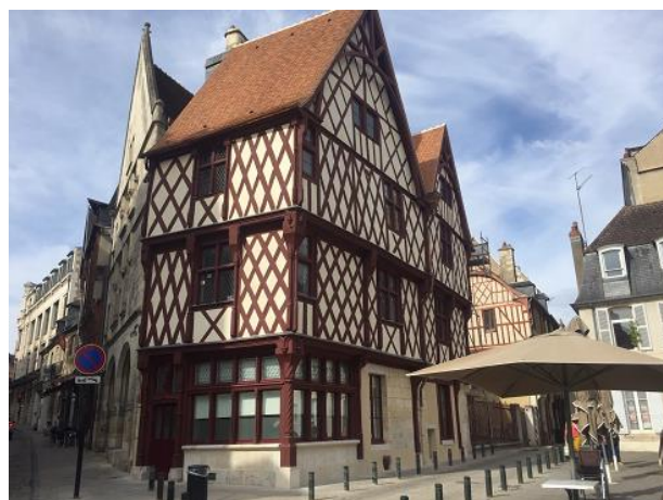
Le bâtiment après restauration
